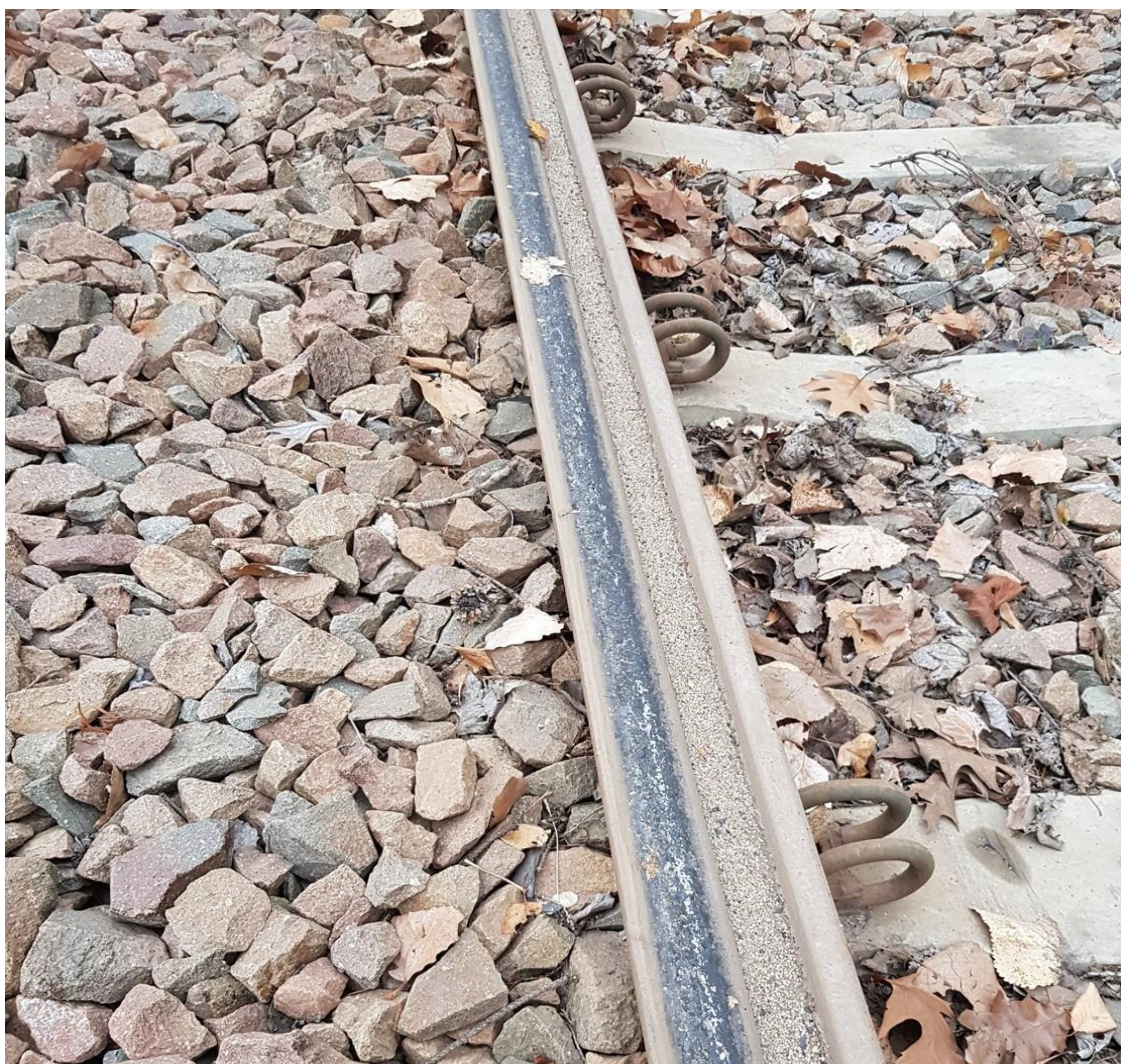
Ryc. 68. Przykład wystąpienia na szynie tramwajowej zjawiska tzw. „mady”
